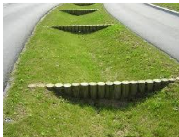
Noue rurale entre voie en pente
