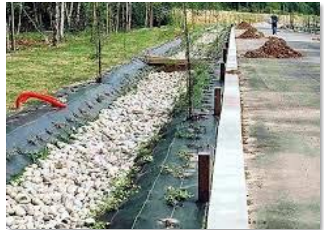
Noue plantée et filtrantes (sols imperméables)
